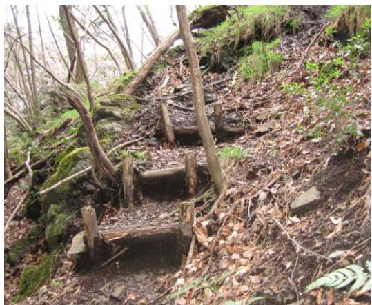
従来から二枚岩北面に設置されていた木製の階段は腐食が進み、修理の必要性がある。今回の調査対象は、修理個所及び新設場所の確認である。調査の結果、二枚岩北面に関しては、全面修理個所 4 か所、新設個所 4 か所である。今年度取り組む階段整備の最優先事業となる。
