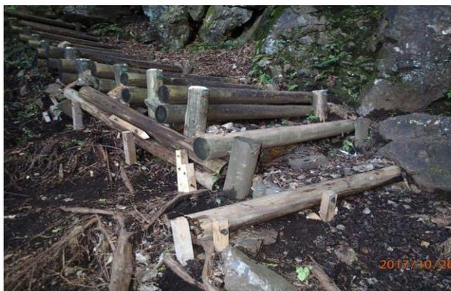
段差の著しい個所には土留対策を施し、石を敷き詰めた結果、階段機能が見事に復活した。石を袋に詰めて運ぶ人、岩を探して運ぶ人、階段を新たに設置する人、分業作業で捗った。
