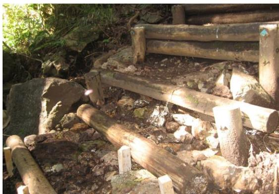
南登山道の階段整備始まる。土が流失し段差が生じ階段機能が失われた既存の木製階段の補修作業である。段差をなくすため付近の岩を運び段差を埋めたり両端に杭を打ち土留対策を施したりしての補修作業である。
