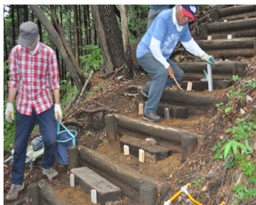
枕木設置作業
