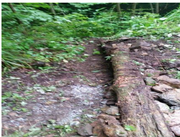
側溝の詰まった土砂の取り除き
