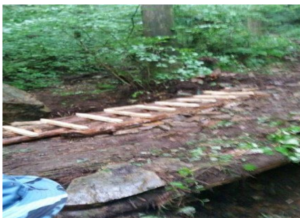
改修した木橋
