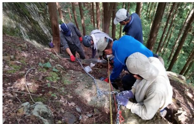
補助用鎖の設置
