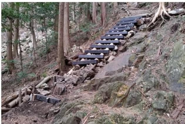
前述した落石は、平成 30 年 11 月 9 日に設置したエコプラスチック製階段を直撃した。平成 31 年 1 月 10 日の定例作業日に全体を取り外し破損個所の修理をすると共に位置修正も行い設置し直した。
