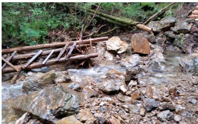
水場上の沢に架かる丸太橋は、10 月 12 日の台風 19 号による大水で氾濫し流失した。(写真左)
