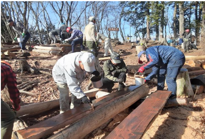
防腐剤塗布班の作業(上写真)
