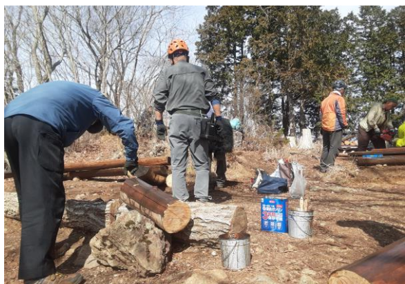
台座の丸太材の防腐剤塗布
