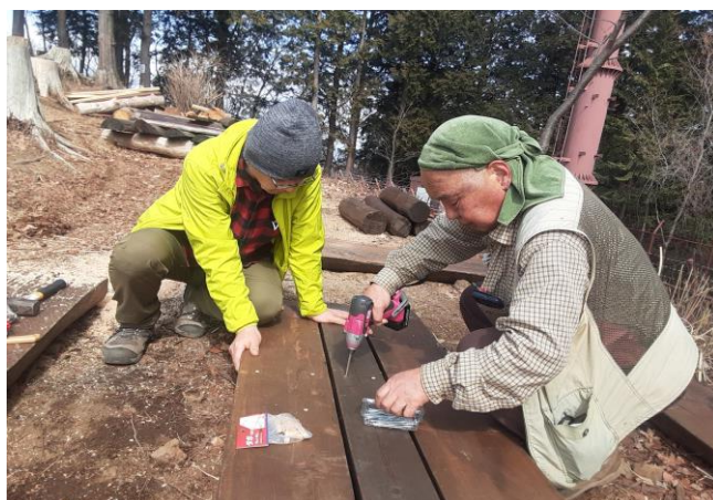
テーブル天板ダボ穴⇒ダボ打⇒コーススレッド止
