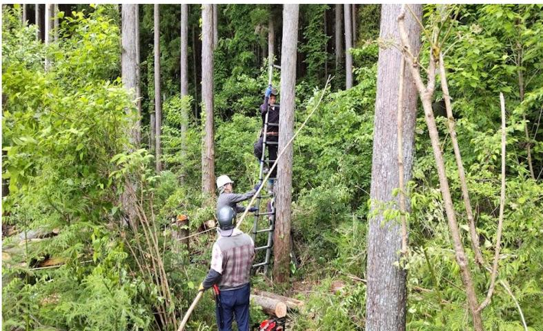
同場所の枯死木伐採作業は第3回目。枯死木10本を伐採した。前段階は枯死木にロープを掛ける。次にチェーンソーの出番、倒したい方向に切込みを入れ、ロープを引っ張る。
